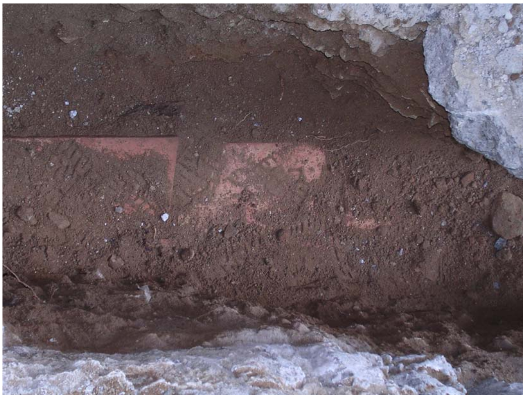
Fotografia 3: Restes d'altres canalitzacions anteriors.
