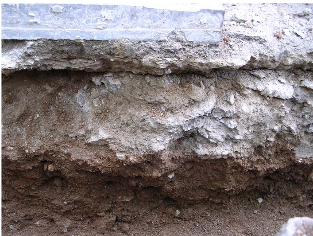
Fotografia 4: Secció de la rasa 100.
