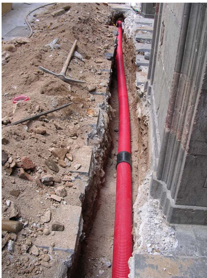
Fotografia 6: Col·locació dels tubs en el tram de La Rambla.
