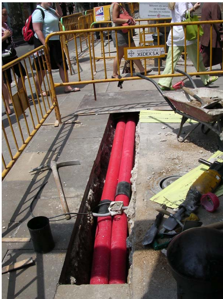
Fotografia 10: Col·locació dels tubs en el carrer de Portaferrixa.
