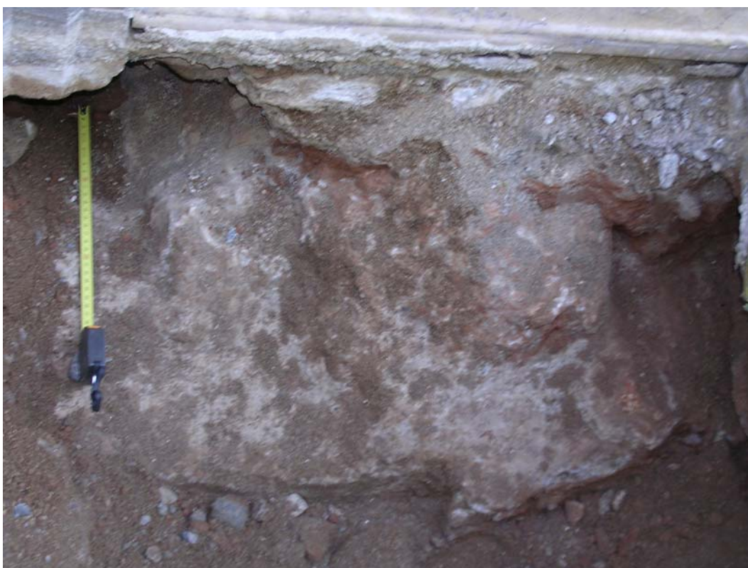
Fotografia 8: Fonamentació U. E. 10005 arrebossada amb morter de calç de color blanquinós.
