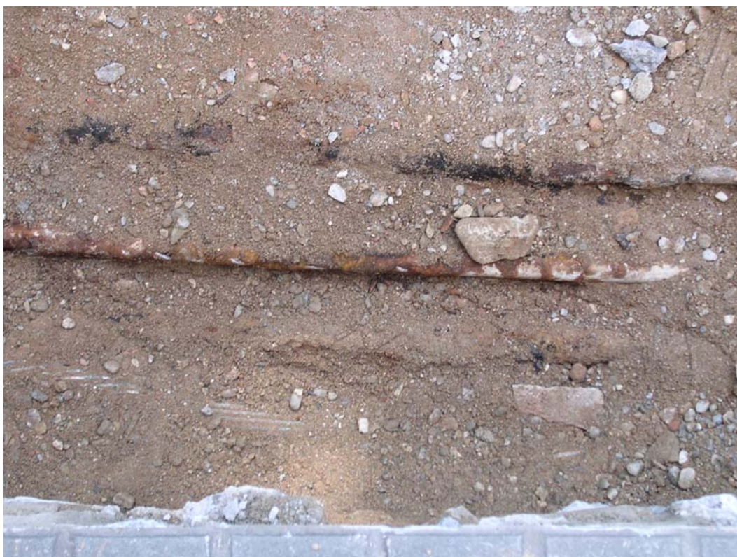
Fotografia 5: Evidències de d'altres serveis en la rasa 100.
